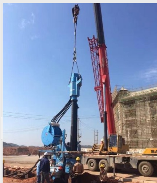
螺旋杆静压施工
