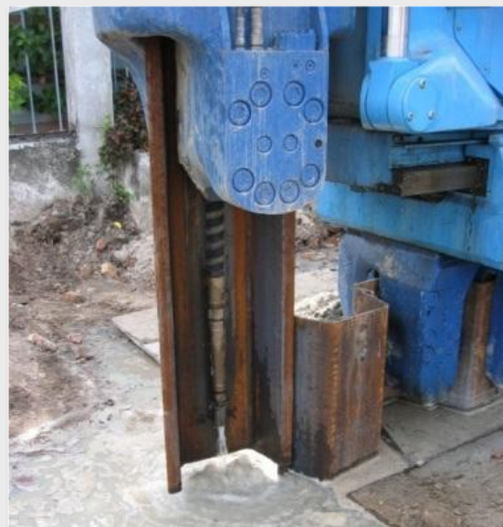
水刀辅助压入施工
